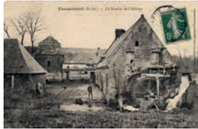
Roue de dessus munie d'augets, moulin de l'abbaye, Foucarmont, ADSM 64Fi959o.
