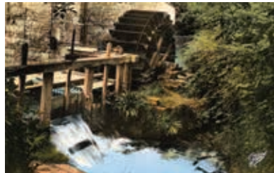
Roue de dessous à aubes, Vieux-moulin, Veules-lès-Roses, ADSM 64Fi237o1.
