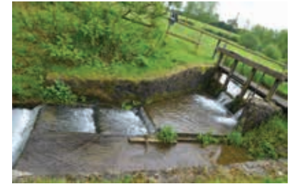
Vannes, ouvertures et passe à poisson (déclivité adoucie par des paliers peu élevés et courts), Gaillefontaine, moulin du Roy. ©Lise Auber Département 76.
