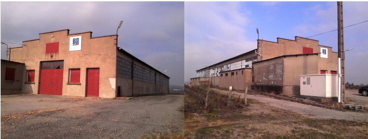
Figure 4. Bâtiment industriel SOGEPO situé en zone agricole (secteur viticole)
