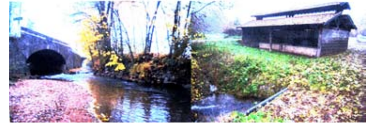
Lavoir et pont de Cercié
