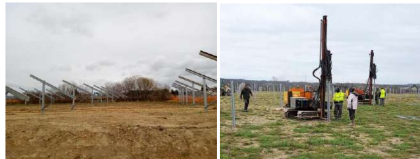
Figure 5 : Mise en place des pieux battus (Source : Chantier IEL)
