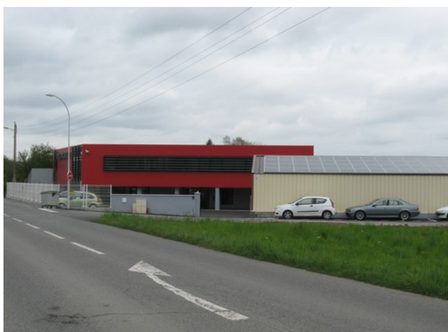
Entreprise Despagnet à Arros-de-Nay
