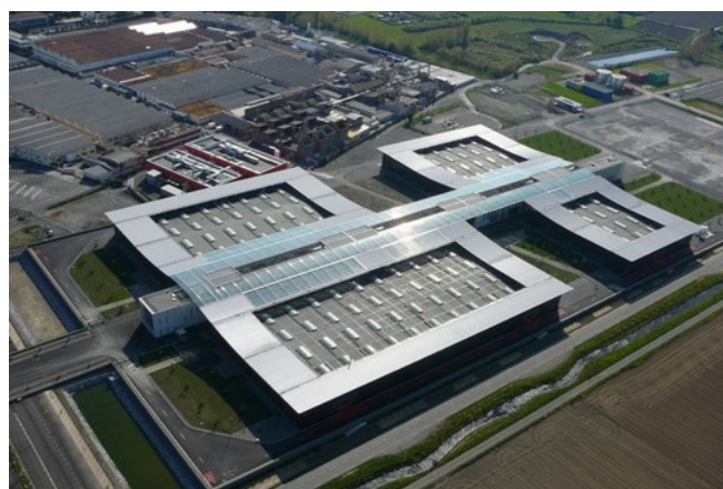
Nouvelle usine Turboméca à Bordes
