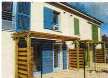
logements collectifs année 2010
