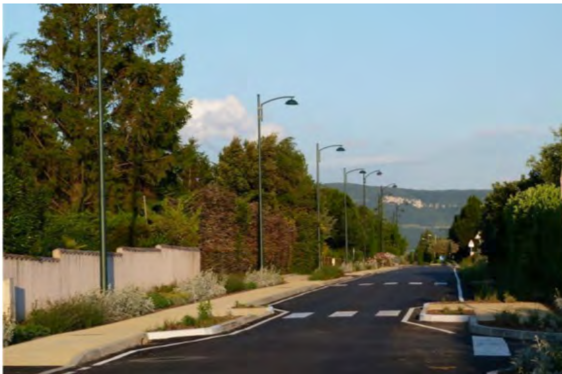
Aménagement de la RD 74
